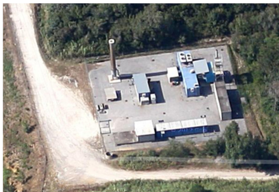
Figura 10 - ex Impianto Biogas - Torcia
