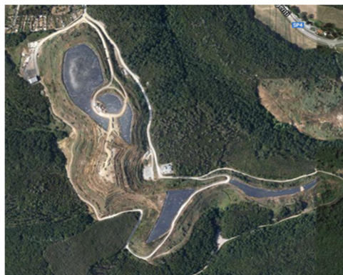
Figura 9- Vista della discarica
